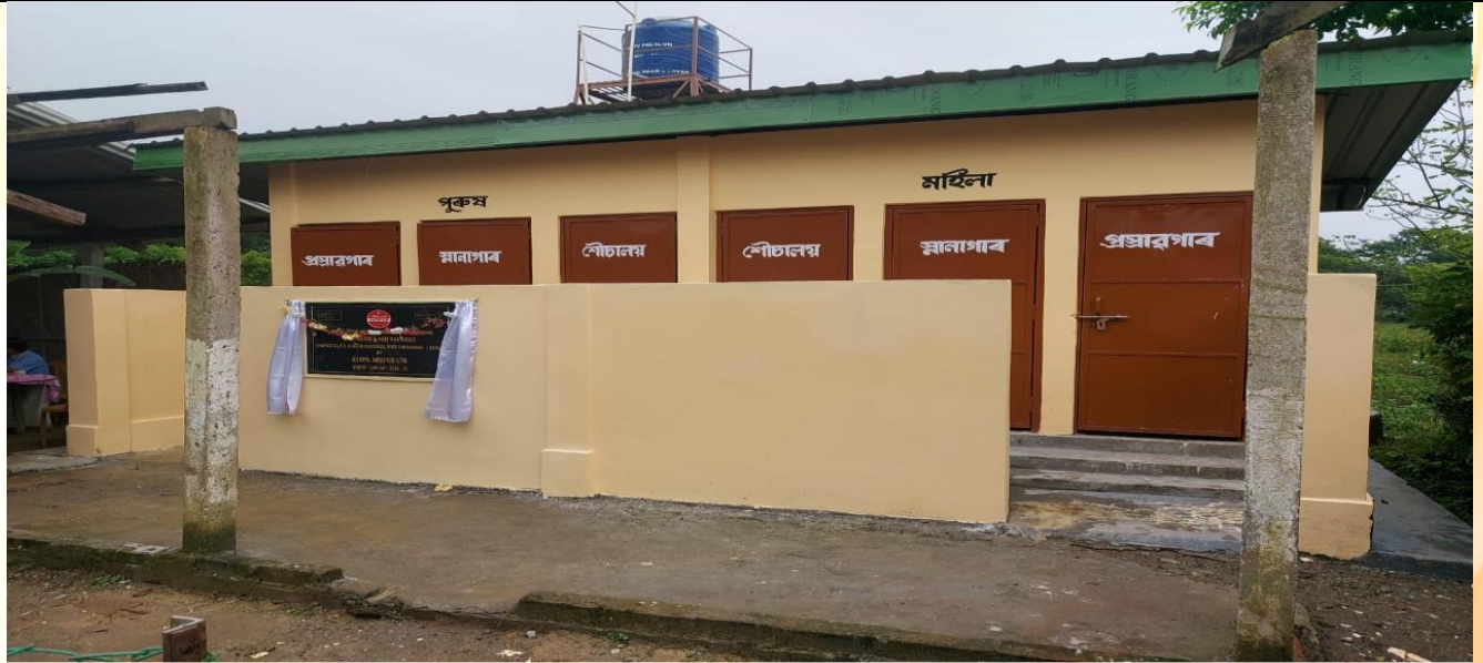
बोरबारी गाँव, नामघर, भदोईपंचाली, डिब्रूगढ़, असम में शौचालय, मूत्रालय और स्नानघर का निर्माण
