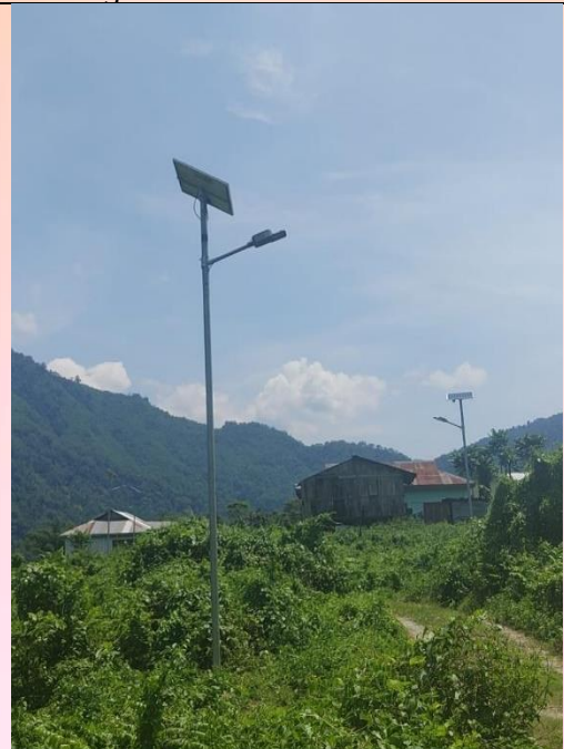
ईएसी परिसर और जनरल ग्राउंड यांगसी, पूर्वी कामेंग जिला, अरुणाचल प्रदेश में एलईडी आधारित सौर स्ट्रीट लाइटिंग प्रणाली की स्थापना
