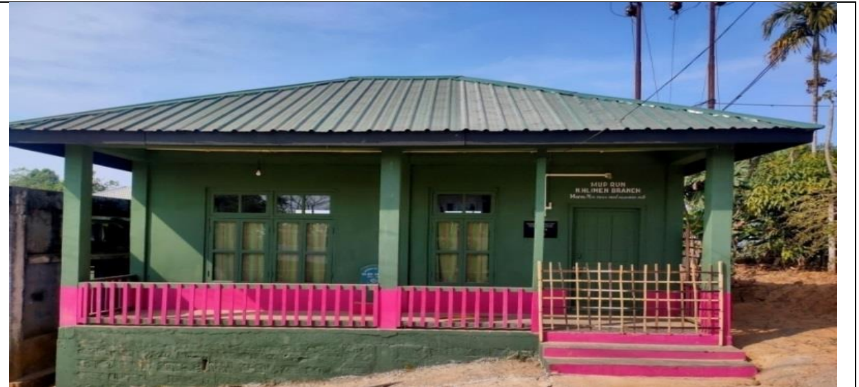
नार्थ हालिमेन गांव, मिजोरम में एमयूपी भवन का निर्माण।
